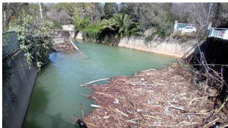
Une action d'envergure a également été menée sur le Las, au dégrilleur du quartier du Jonquet à Toulon, permettant de retirer 335 m<sup>3</sup> de bois mort et de déchets charriés par le cours d'eau lors des crues de février et mars 2024. Cet ouvrage, installé
