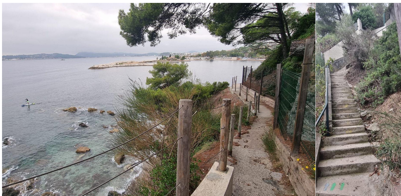
Le sentier et l'escalier
