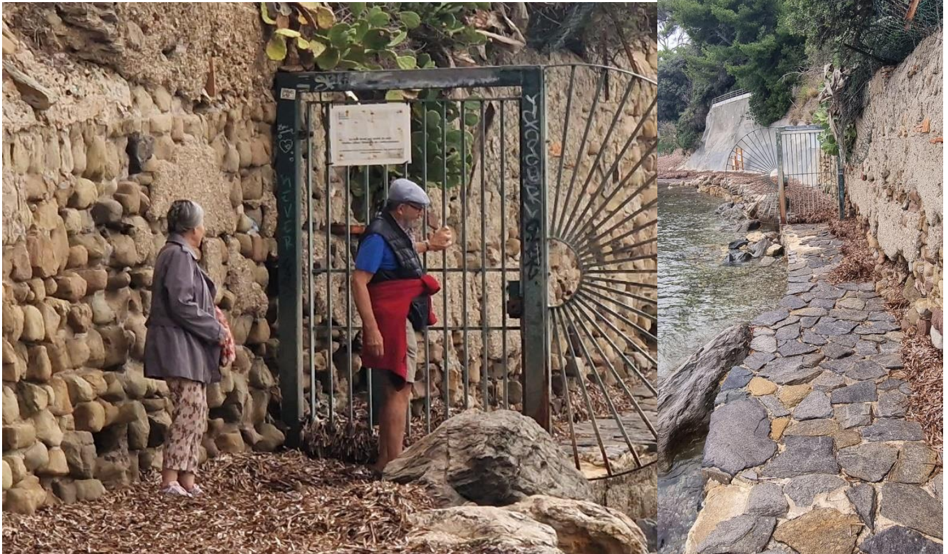
La porte et le mur dégradé
